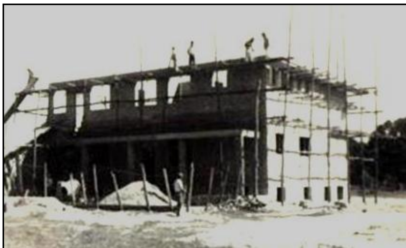
Figura 47 - Construção da casa das religiosas (1959)
