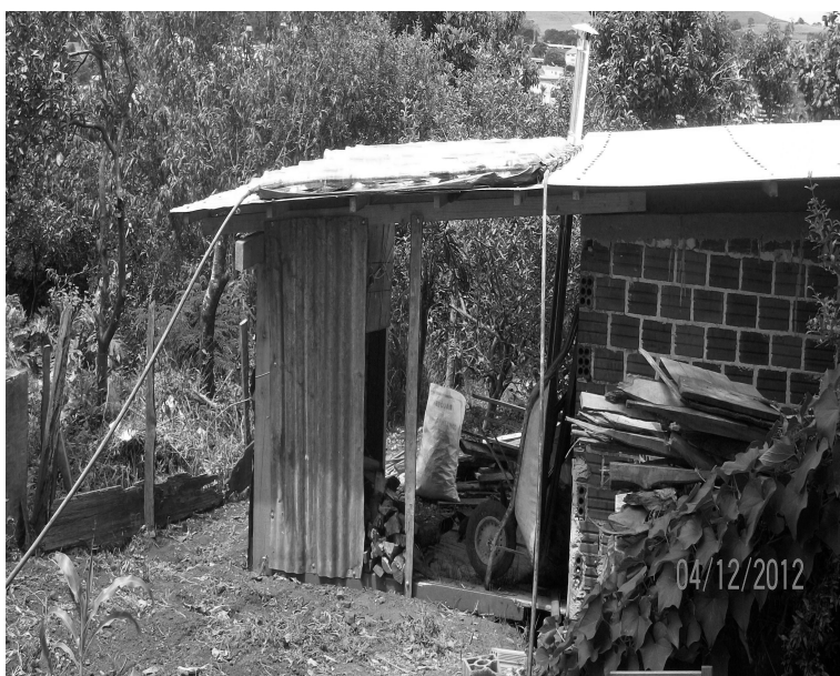
Figura 9- Local de instalação do aquecedor solar reciclável Fonte: A autora (2012).
