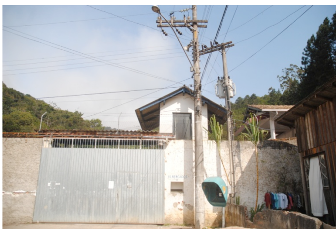
Figura 14 - Entrada da unidade atualmente
