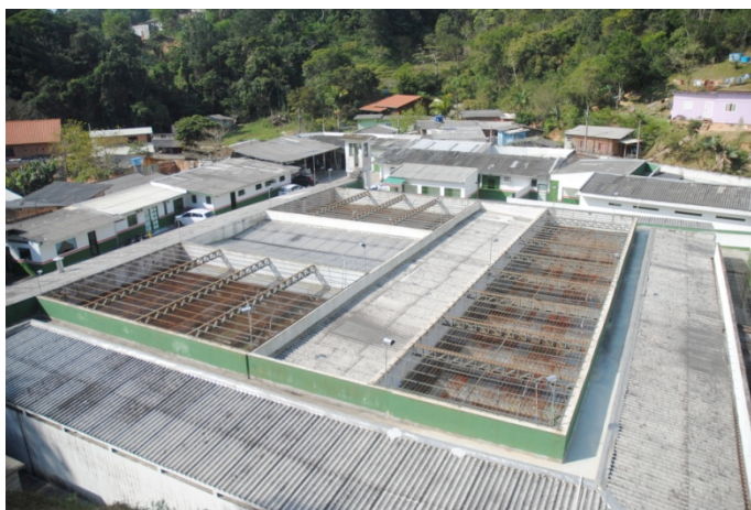
Figura 13 – Vista geral da unidade atualmente
