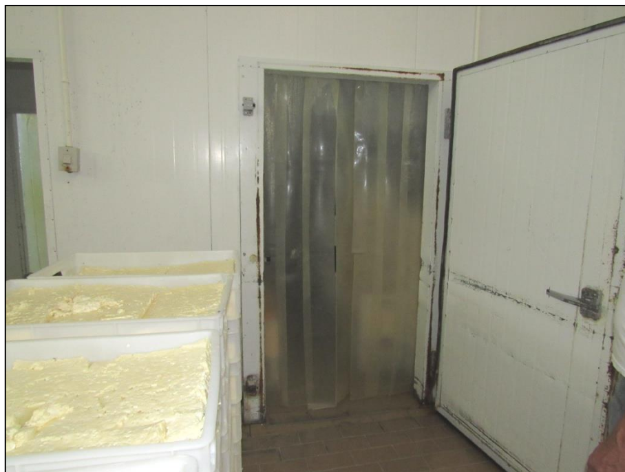
Figura 4 - Acesso à câmara fria para estocagem de produtos.
