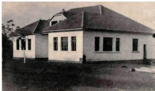
Construções escolares no Rio Grande do Sul — Tipo para zona rural, em alvenaria. para 150 alunos de 1939 a 1944, foram construídos quarenta e quatro deste tipo
