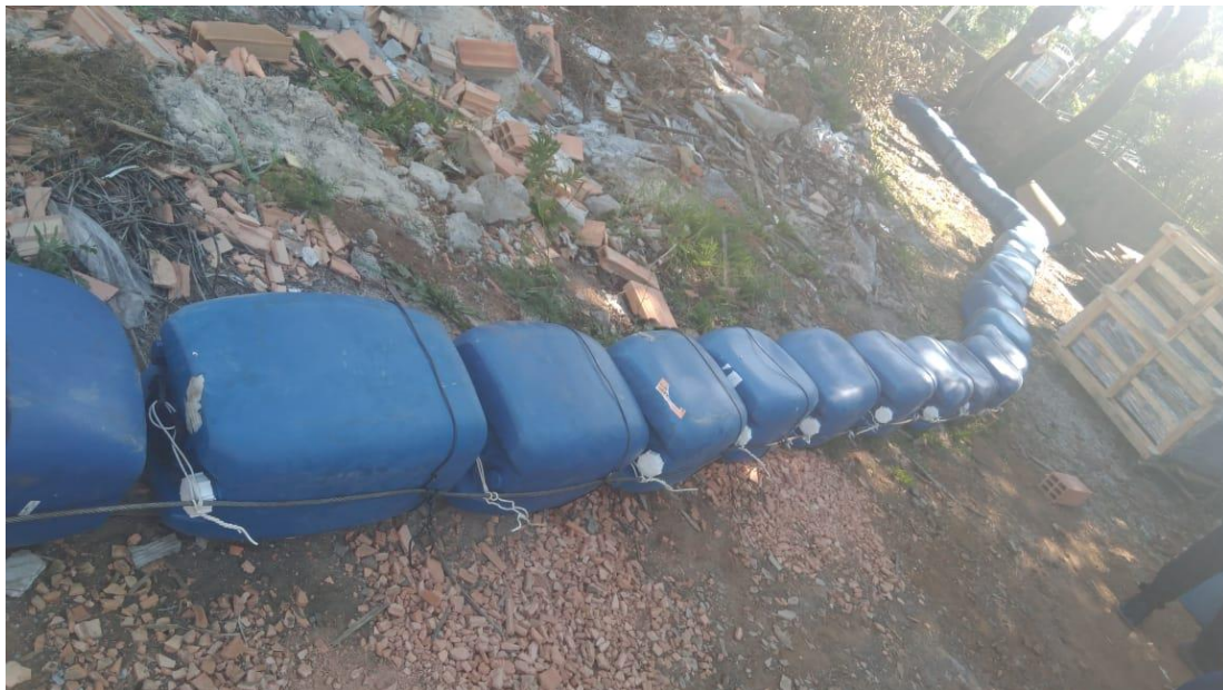
Figura 2- Estrutura da Eco Barreira sendo finalizada.
