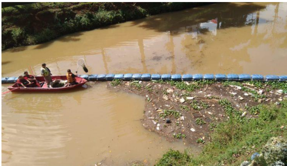
Figura 6 – Remoção do material acumulado na Eco Barreira
