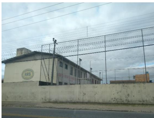
Figura 11 - Fachada da E.E.B. Renato Ramos
