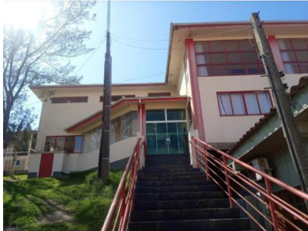
Figura 4- Fachada da E.E.B. Santa Marta
