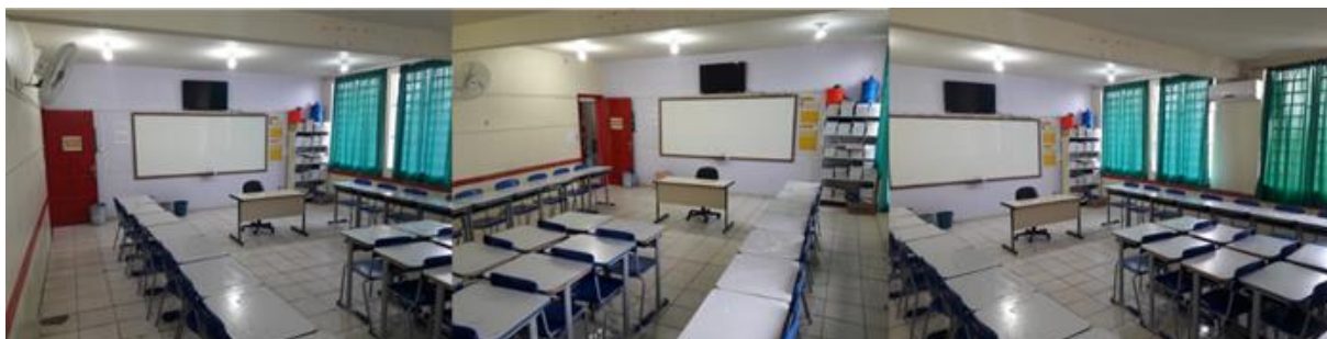
Figura 10 - Sala de aula antes de receber reforma
