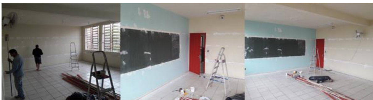
Figura 11- Sala de aula em reforma
