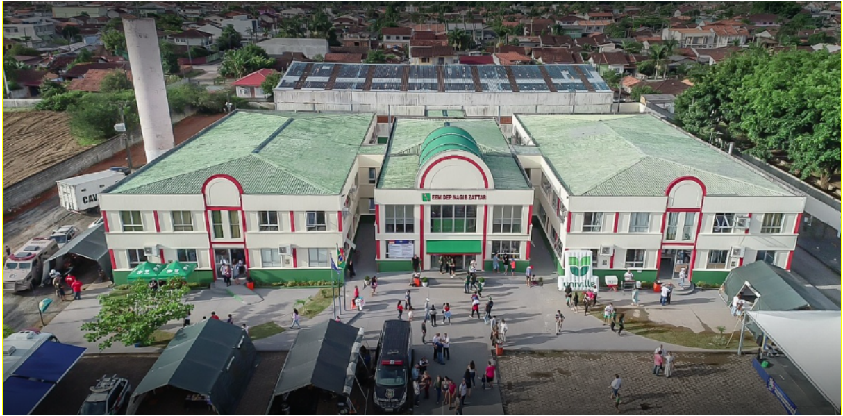
Figura 10: Fachada da Escola Deputado Nagib Zattar
