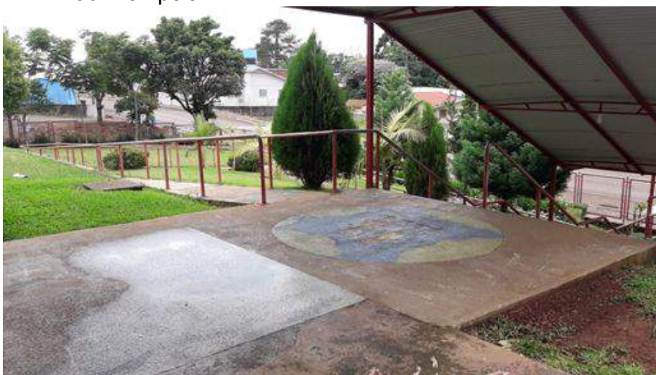
Figura 9: Rampas de acessibilidade para alunos com necessidades especiais da E. E. B. Raul Pompéia
