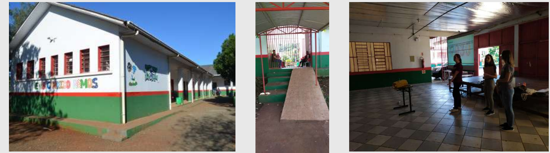
Algumas imagens da escola cândido ramos, mostrando a falta de acessibilidade e infraestrutura para o novo ensino médio.
