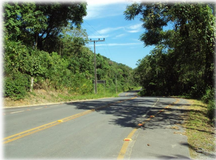
Figura 15: Imagem da estrada pavimentada na Vila da Glória.
