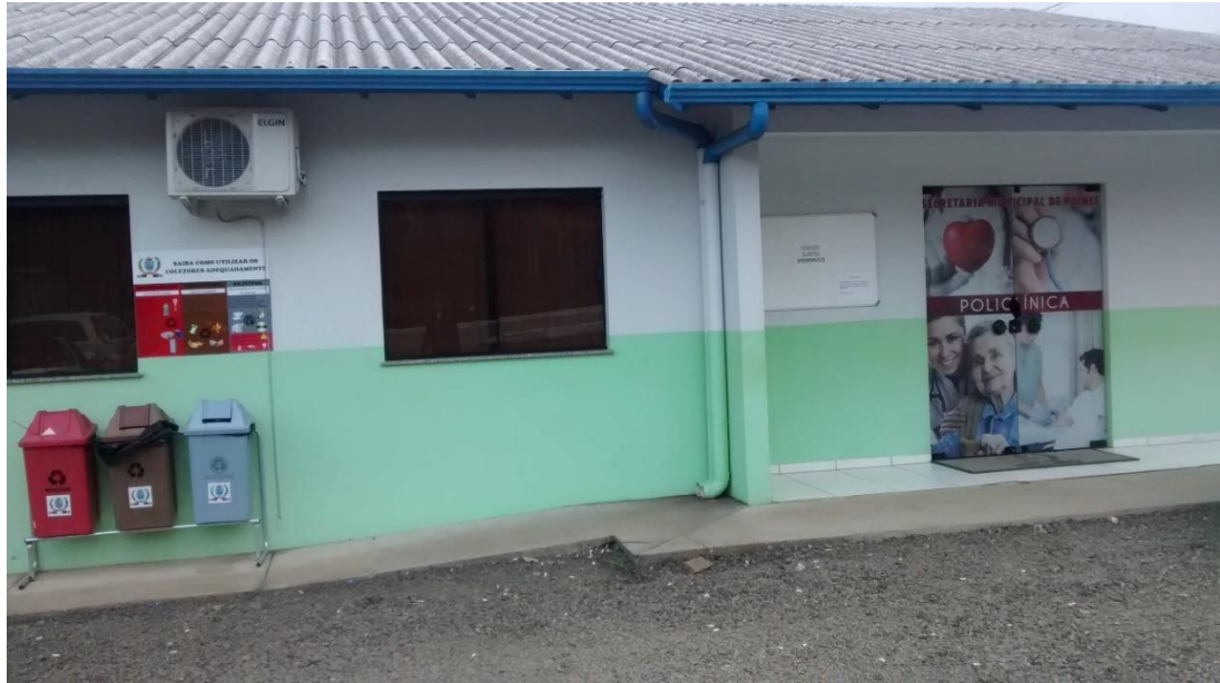
Figura 20: Lixeiras e placa fixada no local de passagem dos servidores. Fonte: Do pesquisador.
