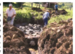
Limpeza do local, colocação do tubo de concreto e das pedras (pedra-ferro)
