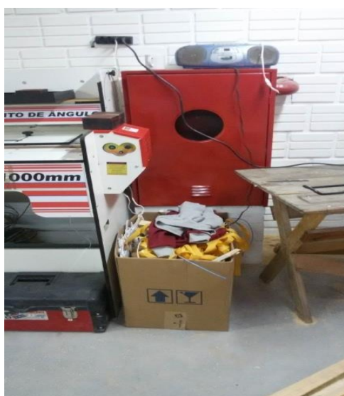
Figura 21 - Hidrante com acesso obstruído Fonte: Autora, 2016.
