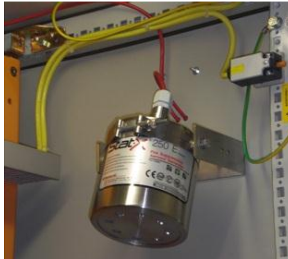
Figura 12: Cilindro de Gás Aerossol Stat-X
