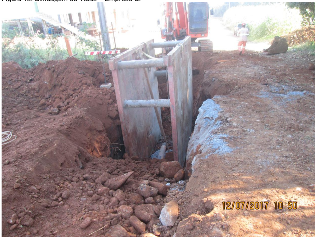
Figura 13. Blindagem de Valas – Empresa B.
