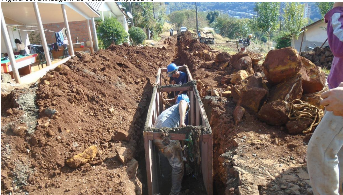
Figura 08. Blindagem de Valas – Empresa A.
