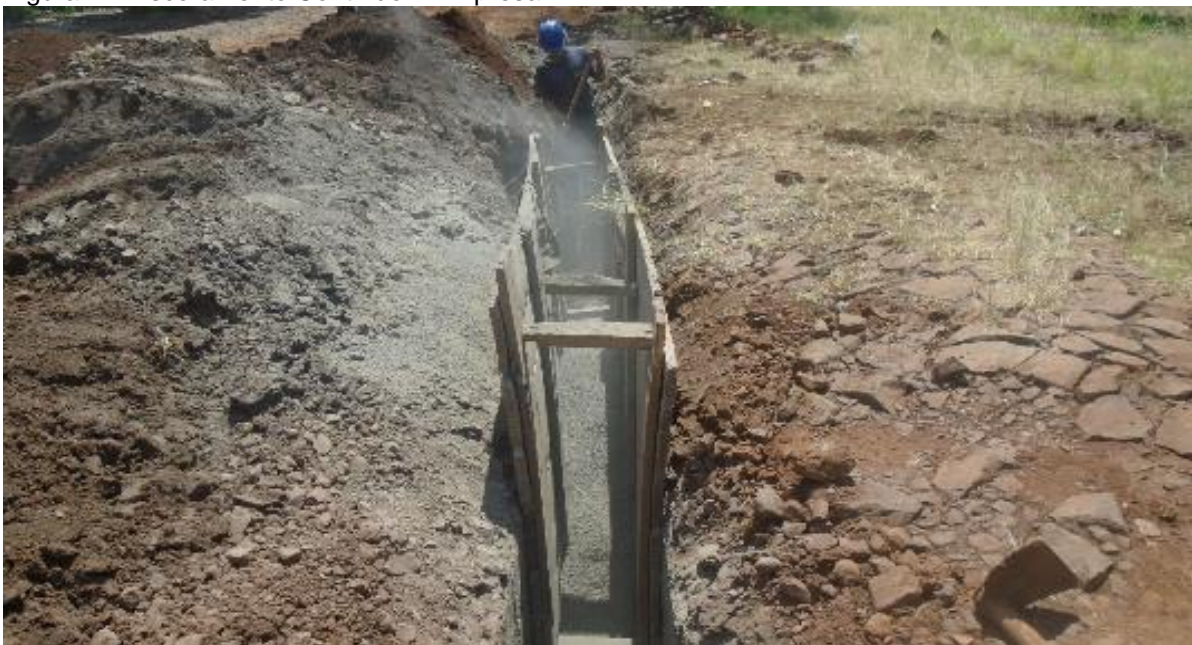
Figura 11. Escoramento Contínuo – Empresa A.
