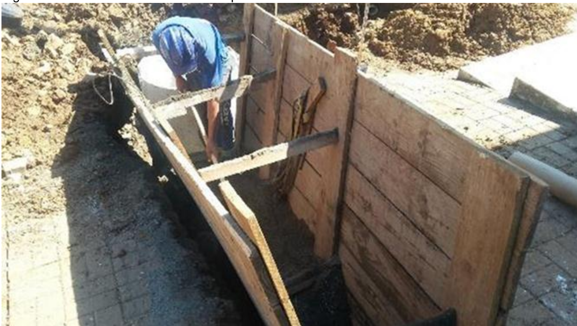
Figura 10. Escoramento Contínuo – Empresa A.
