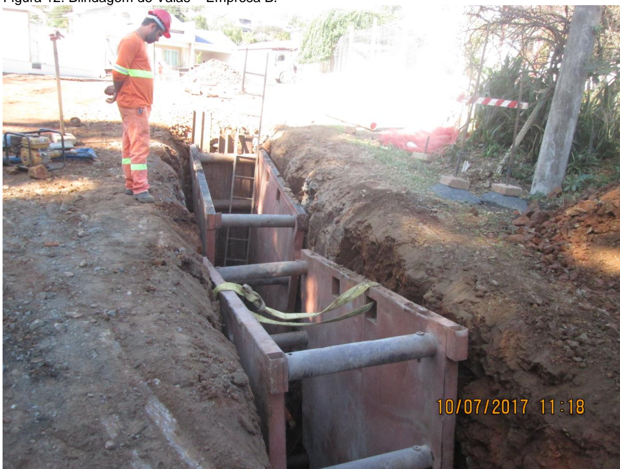
Figura 12. Blindagem de Valas – Empresa B.
