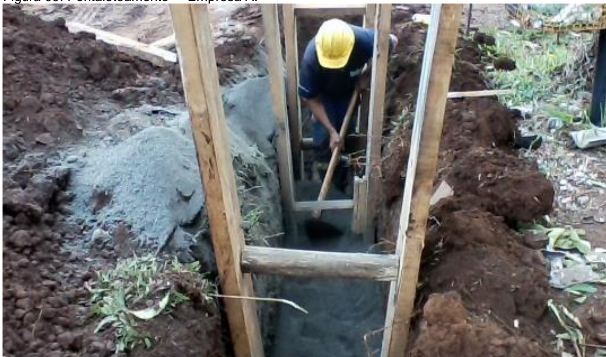
Figura 09. Pontaleteamento – Empresa A.
