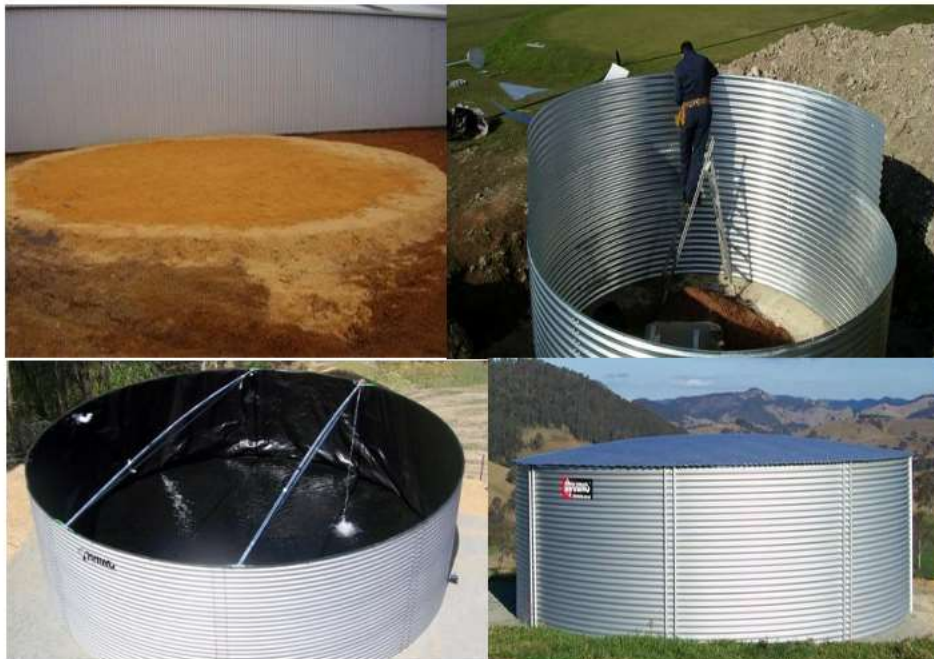
Figura 6: Método construtivo do Reservatório em aço galvanizado
