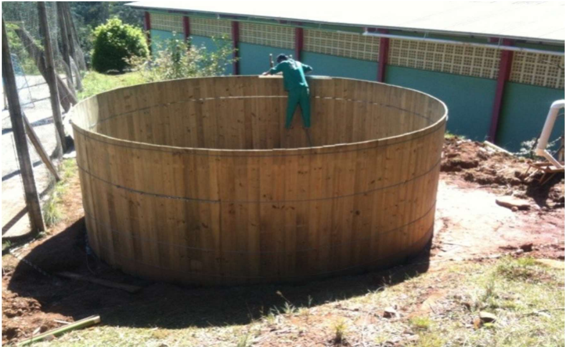
Figura 3: Reservatório de Madeira – Escola Prof. Mansueto Boff, Concórdia – SC
