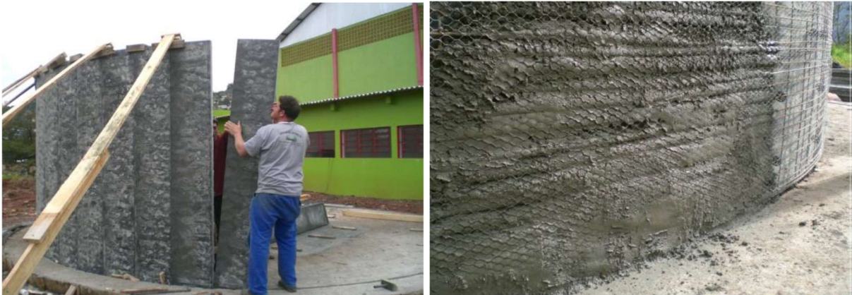
Figura 5: Montagem das placas de ardósia, armadura e argamassagem manual
