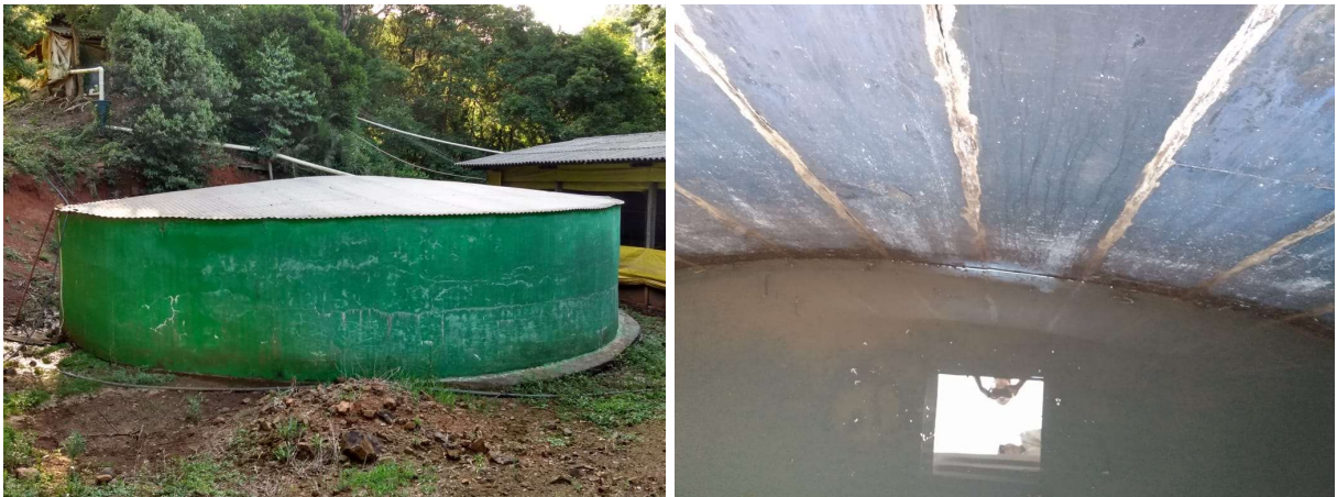
Figura 14: Vista externa (argamassado) e interna (placa de ardósia) do reservatório
