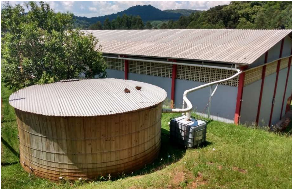
Figura 13: Reservatório de madeira de 60m 3
